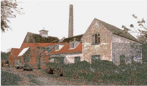
Skørpinge, Sydstevn's Andelsmejeri, opført 1886 og 1953
