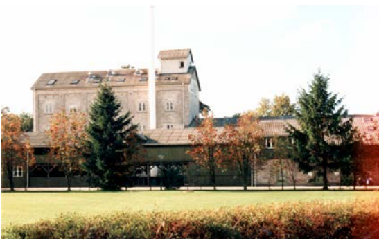
Jernbanegade 4 Richters gamle pakhus i dag indrettet til boliger
