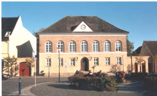
Nytorv Tinghus, opført 1830, Arkitekt J. H. Koch.
